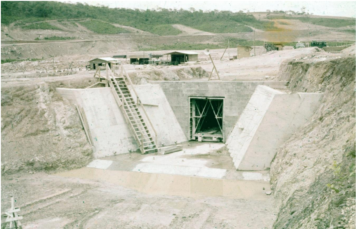
Obras da barragem do Lago Paranoá, em Brasília (Arquivo Público do DF)
